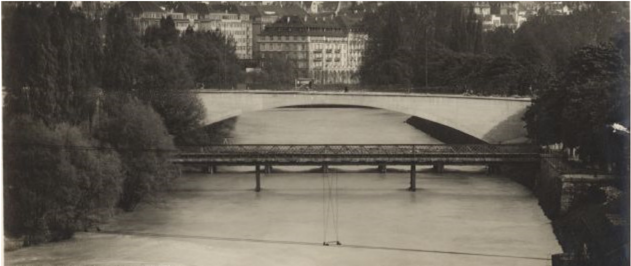
Lettensteg und Kornhausbrücke, 8005 Zürich (um 1920)
